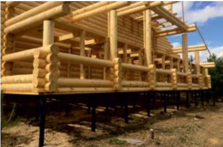
Фундамент из винтовых свай используется в первую очередь при строительстве домов на слабых подвижных грунтах. К ним относятся болотистые и торфяные почвы. Такое основание целесообразно использовать и при высоком уровне грунтовых вод.
