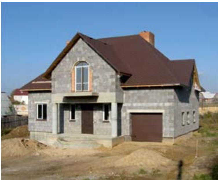
Основное достоинство **домов из керамзитобетонных блоков** – это теплопроводность стен. Дома, построенные из таких блоков, очень хорошо держат тепло внутри себя, если конечно соблюдена технология, как производства, так и монтажа блоков. Это происходит благодаря пористому наполнителю – керамзиту.
